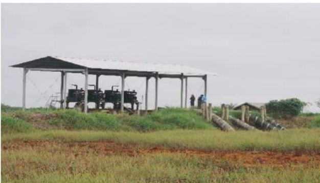
Gambar 24. Pompa PT. SAM untuk Membuang Air di Perkebunan Ketika Musim Hujan
